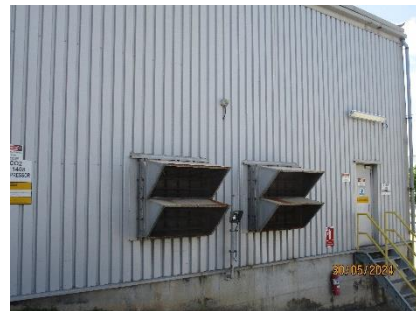
ภาพที่ 2.1-8 ติดตั้งอุปกรณ์ลดเสียง
